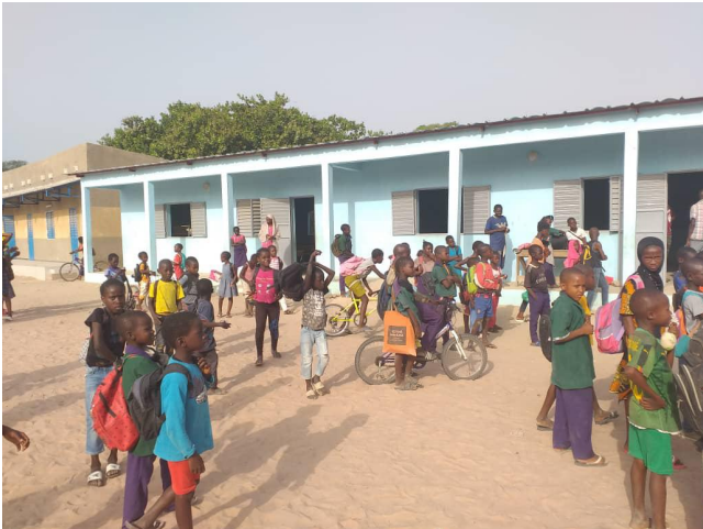
Voorraanzicht 2 nieuwe klassen. In 2019 gebouwd.
